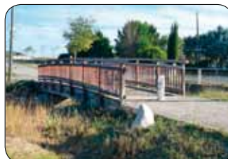
Pont de la piste cyclable, Route de Saint Paul
